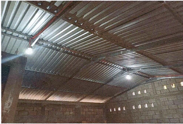
Foto 3: Mejoramiento y reparación de Sistema Eléctrico
