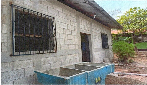
Foto 1: Mejoramiento, reparación o sustitución de área de cocina
