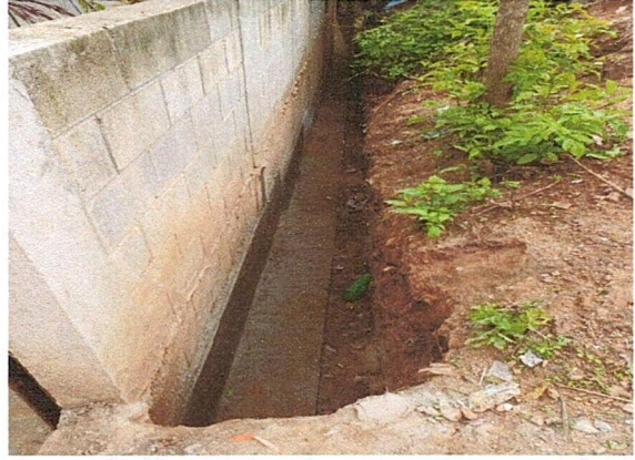
Foto 2: Mejoramiento de cuneta de concreto
